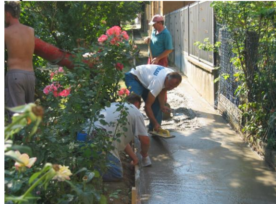
A képen: Járdabetonozás a Dózsa utcában.
